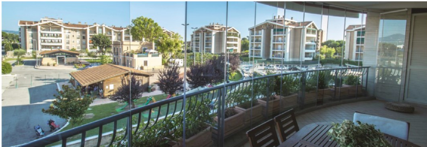
Terrazze. Anche le strutture sui balconi possono usufruire del bonus 50 per cento. Nella foto una realizzazione di Vetrate Panoramiche Italiane
